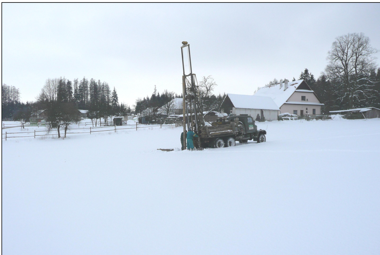
Foto č.14: Celkový pohled na vrtnou soupravu UGB při hloubení průzkumného vrtu V3 za osadou Rytířsko
