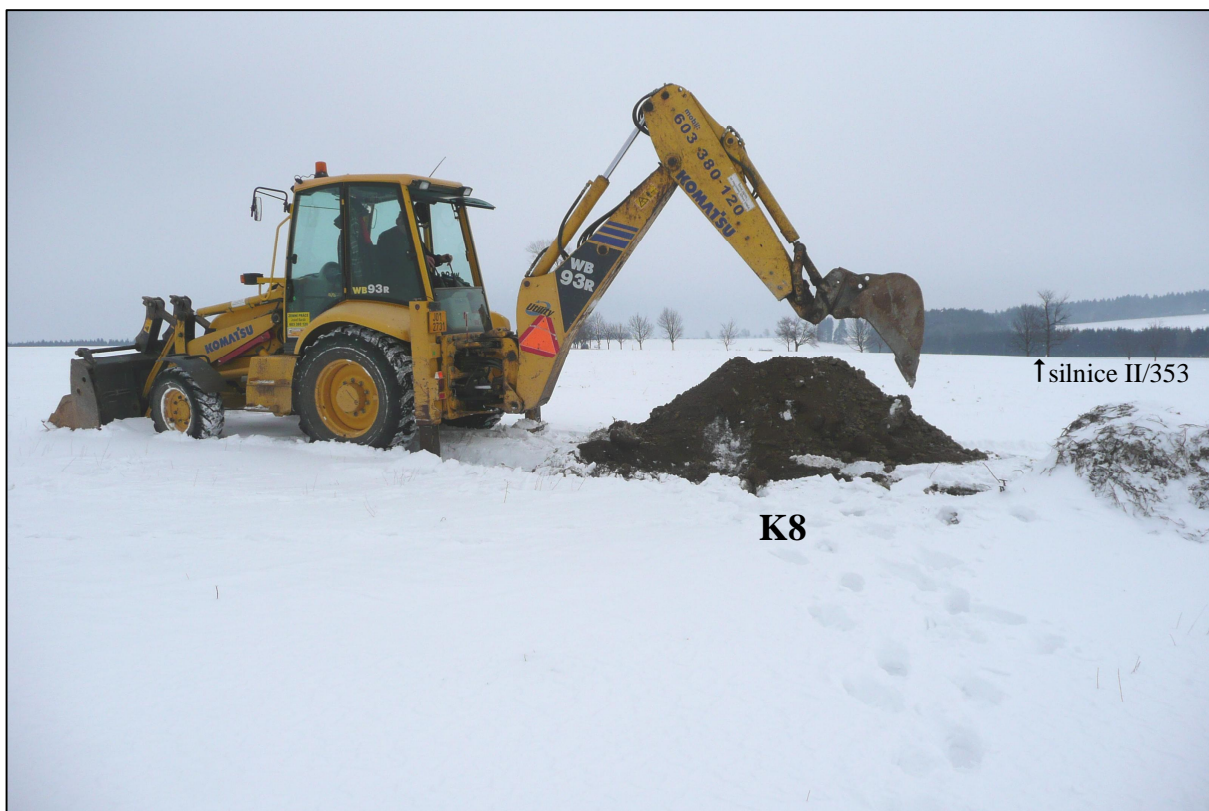
Foto č.6: Pohled na hloubení průzkumné sondy K8. V pozadí stávající silnice II/353.
