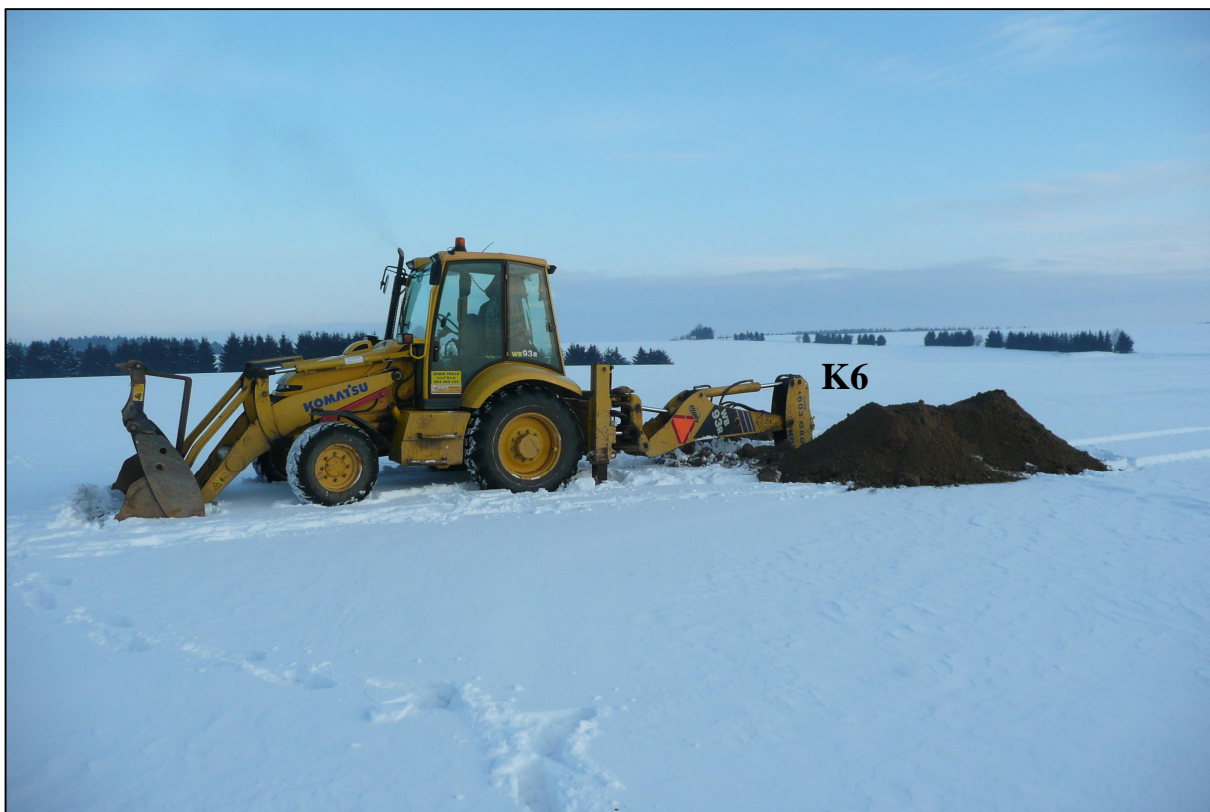
Foto č.3: Hloubení průzkumné sondy K6 kolovým bagrem Komatsu.
