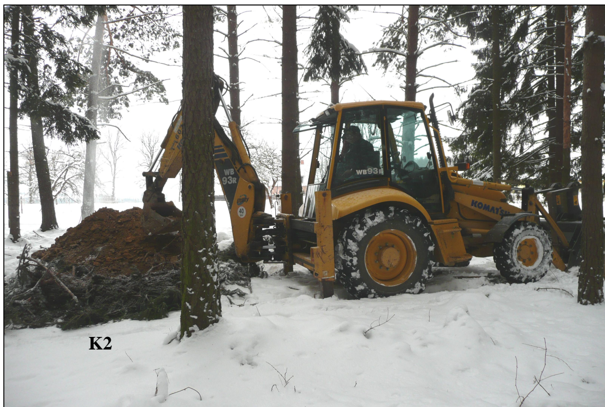
Foto č.2: Hloubení průzkumné sondy K2. V pozadí za lesem osada Rytířsko.
