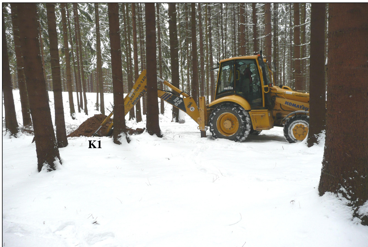
Foto č.1: Hloubení průzkumné sondy K1 kolovým bagrem. V pozadí násyp stávající silnice.
