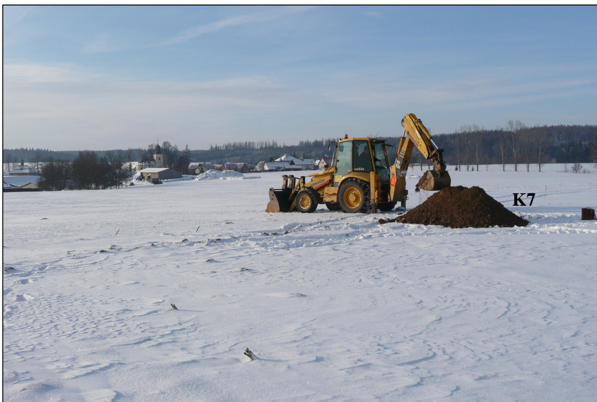
Foto č.4: Hloubení průzkumné sondy K7 v trase projektovaného obchvatu obce Jamné.
